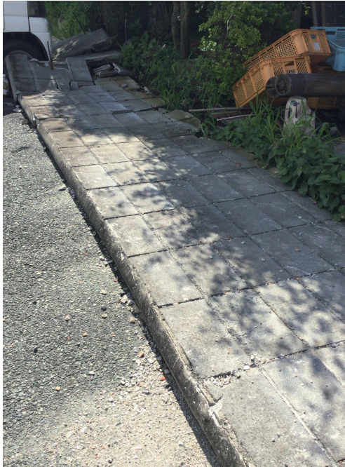
地震によりブロック塀が倒壊
