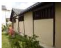
北控所や渡廊下の土壁修理後
