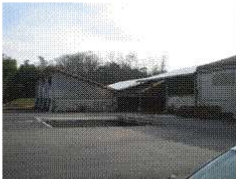
図8 伊賀北部農業協同組合による 堆肥製造施設①
