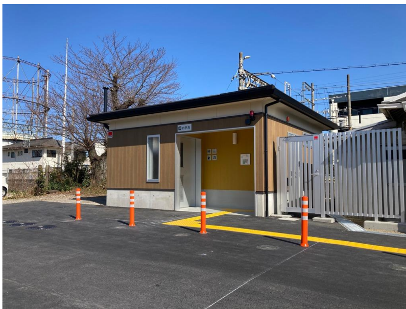
解体新築した茅町駅バリアフリースイレ
