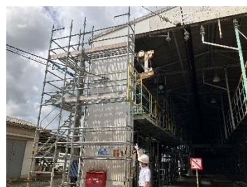
車庫耐震補強
