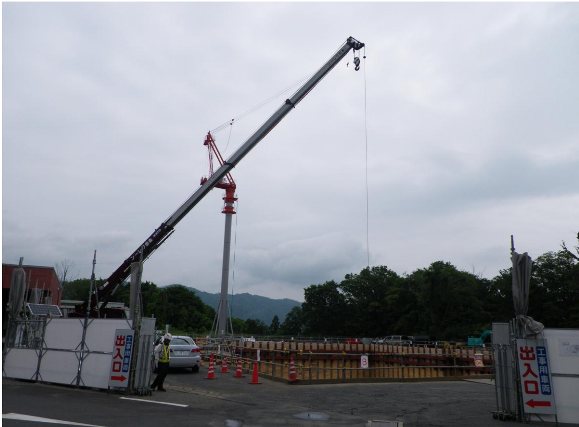
○現場全体（南西端から）
