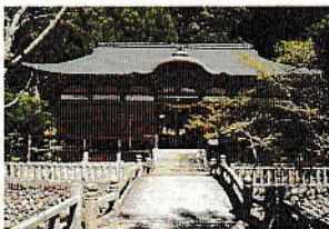
解体工事前の拝殿
