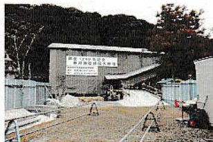
解体工事着手・素屋根
