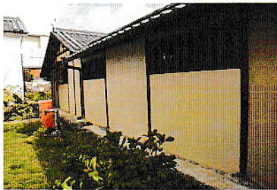
北控所や渡廊下の土壁修理後
