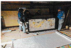
解体工事前の絵馬搬送
