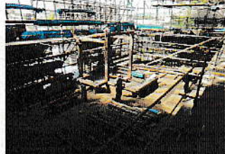
解体工事の様子
