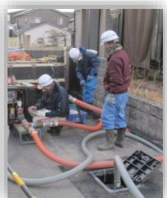
管路洗浄の様子
