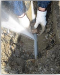
漏水修繕の様子
