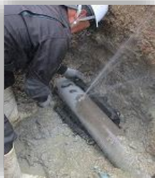
漏水修繕の様子
