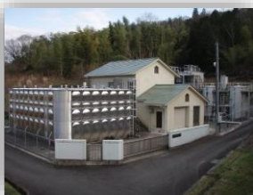
水道施設の外観
