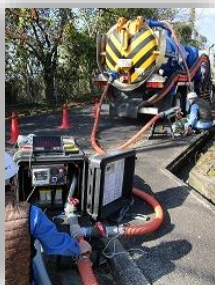
管路洗浄の様子
