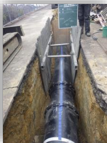
管路の耐震化更新工事
