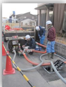
管路洗浄の様子
