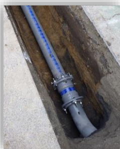
管路の耐震化更新工事
