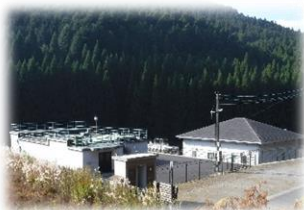
水道施設の外観
