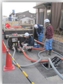
管路洗浄の様子
