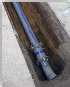
管路の耐震化更新工事
