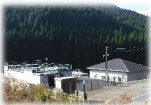
水道施設の外観
