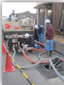
管路洗浄の様子
