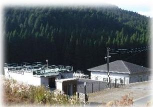
水道施設の外観
