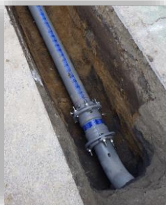
管路の耐震化更新工事
