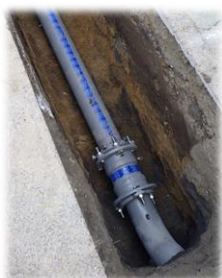
管路の耐震化更新工事
