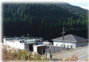
水道施設の外観
