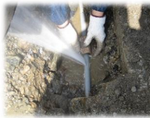
漏水修繕の様子
