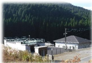
水道施設の外観
