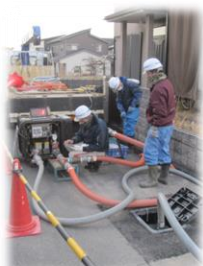
管路洗浄の様子
