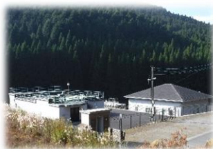
水道施設の外観
