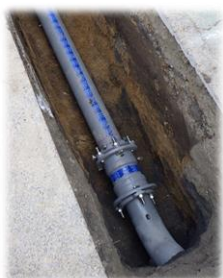
管路の耐震化更新工事
