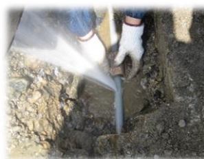
漏水修繕の様子
