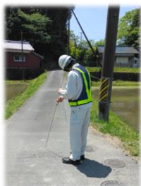
漏水調査の様子
