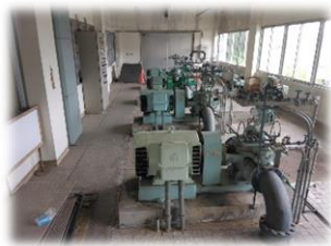
送水ポンプ棟
