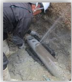
漏水修繕の様子
