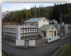
水道施設の外観
