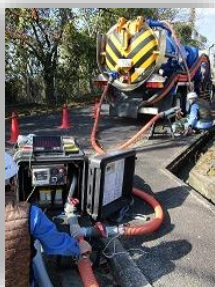
管路洗浄の様子
