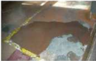
床仕上げの剥がれ
