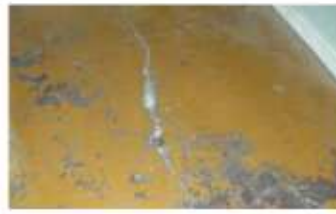
床のひび割れ
