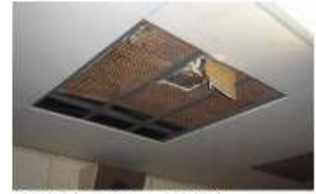
天井材の落下・剥がれ
