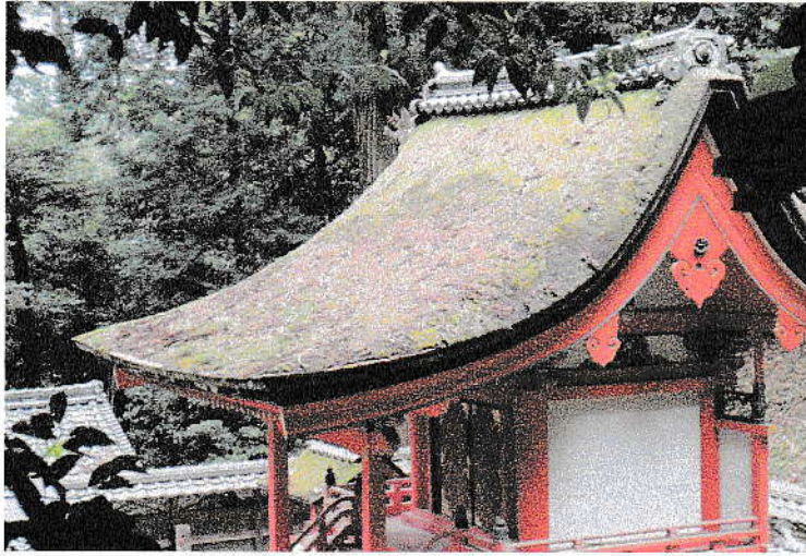
重文猪田神社本殿 檜皮屋根 葺替前
