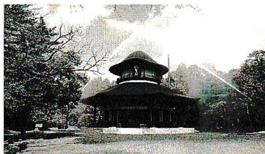
俳聖殿での一斉放水状況
