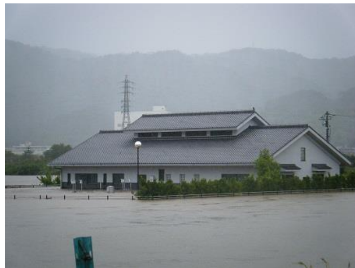
【大雨による処理場の浸水状況】
