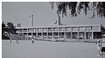
竣工間もない頃の旧上野市庁舎
