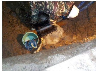
漏水修繕の様子
