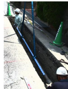
管工事の状況
