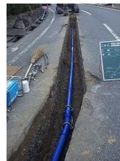
管工事の状況
