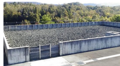
ゆめが丘浄水場 天日乾燥床
