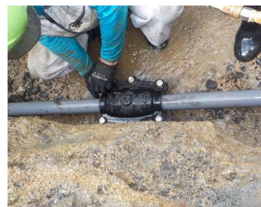
漏水修繕の様子
