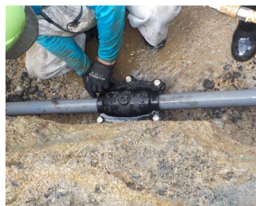
漏水修繕の様子
