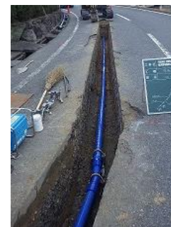
管工事の状況
