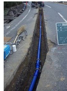
管工事の状況
