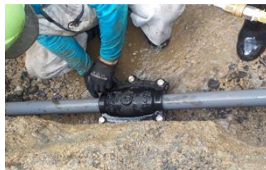
漏水修繕の様子
