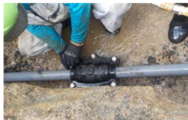
漏水修繕の様子
