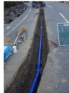
管工事の状況
