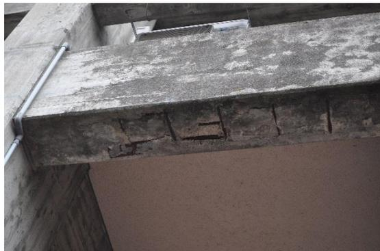
東側2階ベランダ下面鉄筋露出状況
