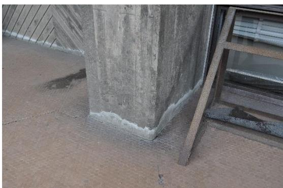
南側外柱 基礎部分補修状況
