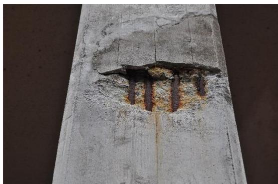
東側外柱 コンクリート剥離状況
