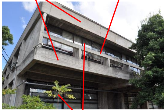
基準 2: スチール建具、基準 3: 窓ガラス
