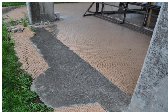
東側ピロティ 補修状況
