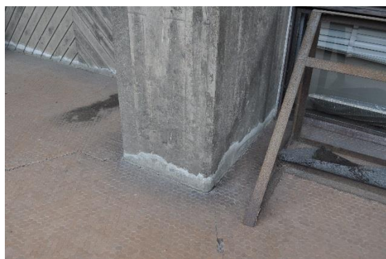
南側外柱 基礎部分補修状況
