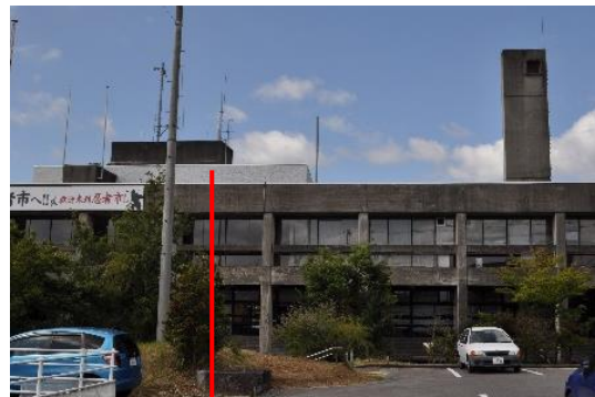
基準 2: RC の外壁 (議会棟外壁)
