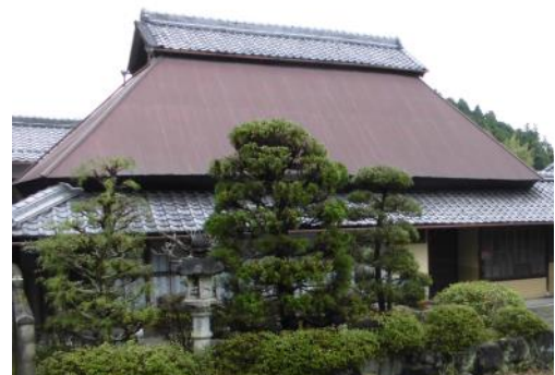
木造茅葺トタン葺平屋建て住宅
