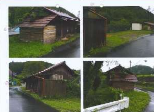
整備前の写真
