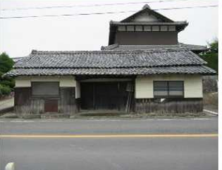
整備前の写真
