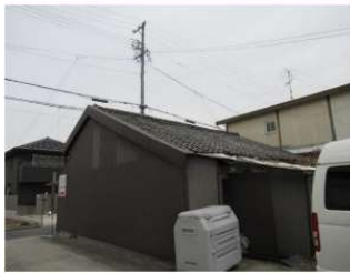
整備前の写真
