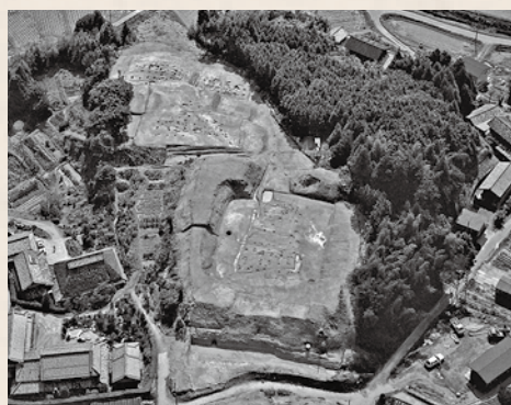
発掘調査後全景写真（北から） 手前が主郭にあたる
