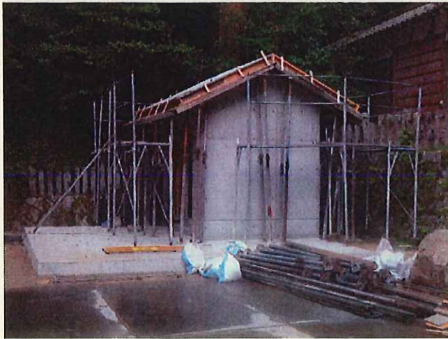
重文 猪田神社本殿 防災施設整備（建造物）事業（国補助）
