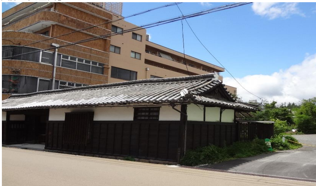
【改修前の長屋門】
