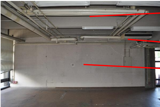
基準 5: 露出配管
