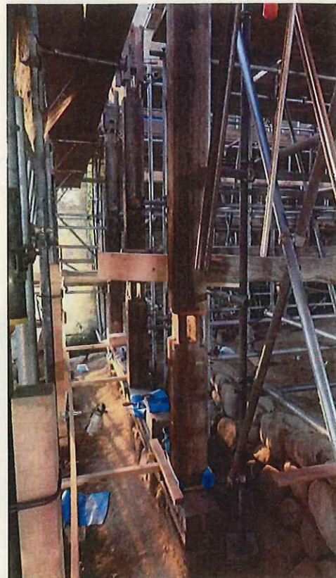
柱の仮組み立て
