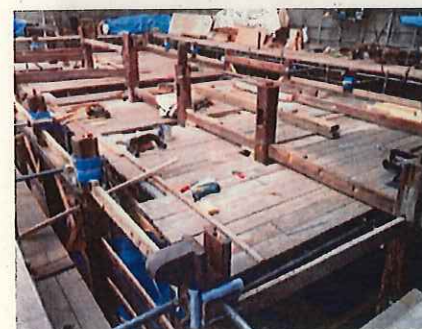
13. 桁・頭貫解体作業
