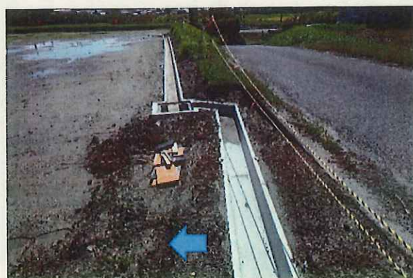
▲ 整備区域西端の排水溝
