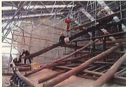
4. のすみぎ 野隅木解体作業
