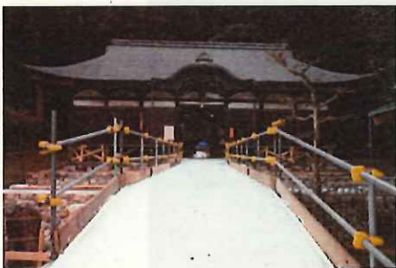
1. 仮設通路設置完了
