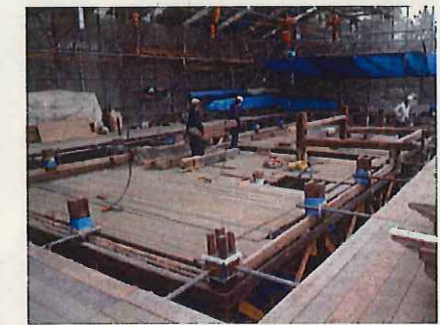
12. かしらぬき 桁・虹梁・頭貫解体後
