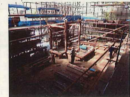
15. 解体作業完了
