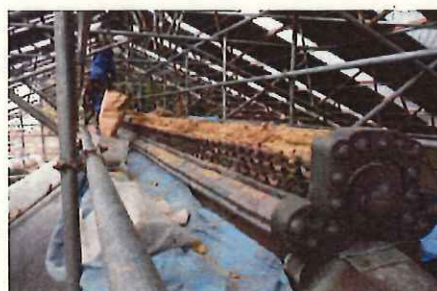
8. 棟瓦の解体状況
