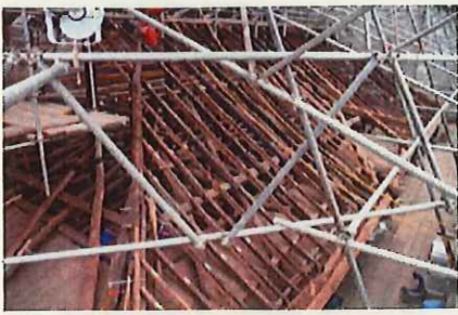
1. のじいた 野地板解体後
