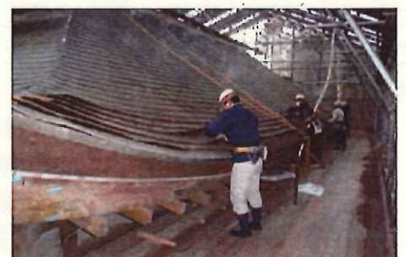
9. 銅板の解体作業
