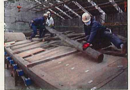
6. はねぎ 桔木解体作業
