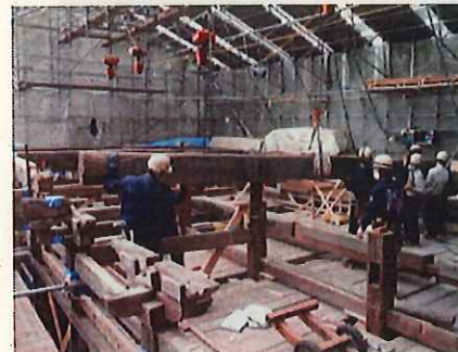
10. こうりょう 虹梁解体作業
