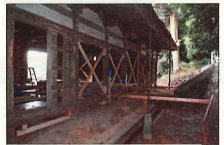
6. 壁板の解体と仮補強
