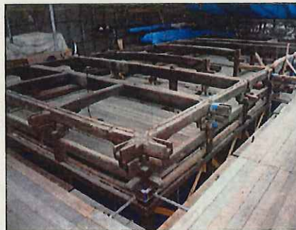
11. 軒廻り・壁解体後
