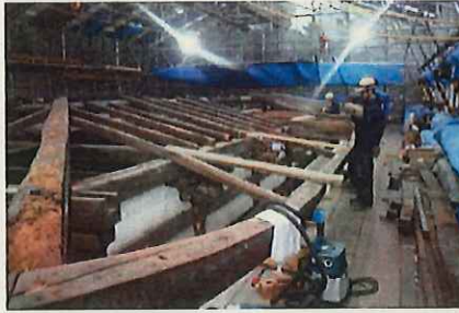
8. のきまわ 軒廻り解体作業
