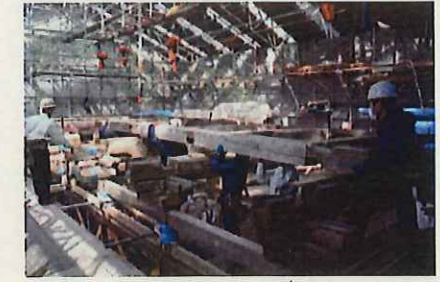
9. けた 桁解体作業
