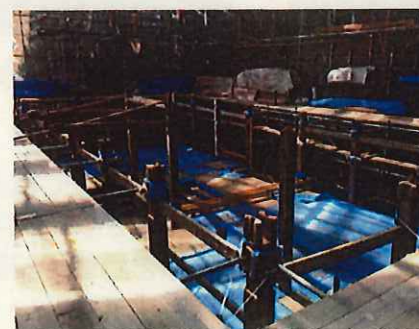
14. 柱・頭貫解体作業
