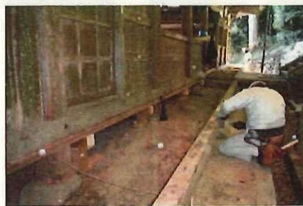
5. 縁の解体作業
