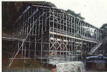
2. 素屋根設置作業
