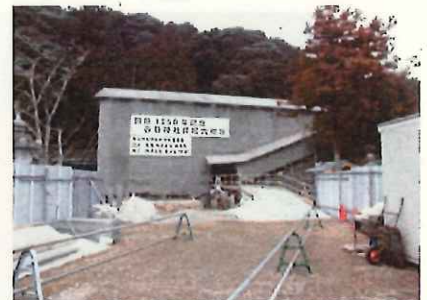
3. 素屋根設置完了
