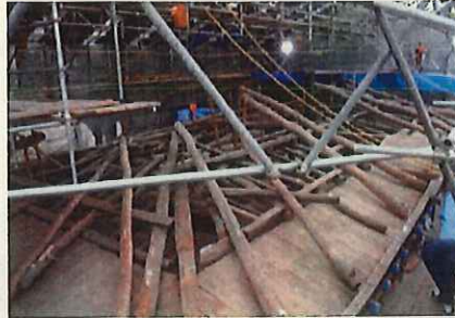
5. こやぐみ 小屋組解体後
