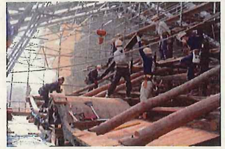
3. もや 母屋解体作業
