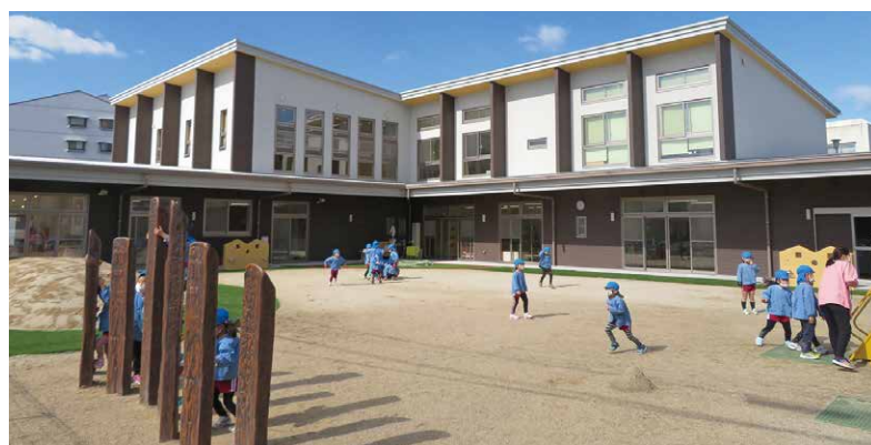
改築支援を行った私立みどり第二保育園園舎
