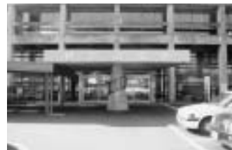
伊賀市役所 (本庁・上野支所)
