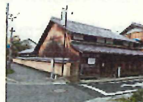
史跡芭蕉翁生・工事着手前（平成29年度）
