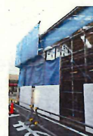
工事着手後（令和2年度）
