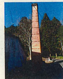
丸柱に残るガス窯の煙突
