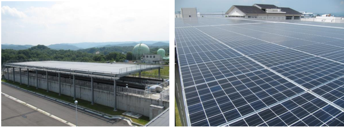
図 3-9 ゆめが丘浄水場における太陽光発電設備
