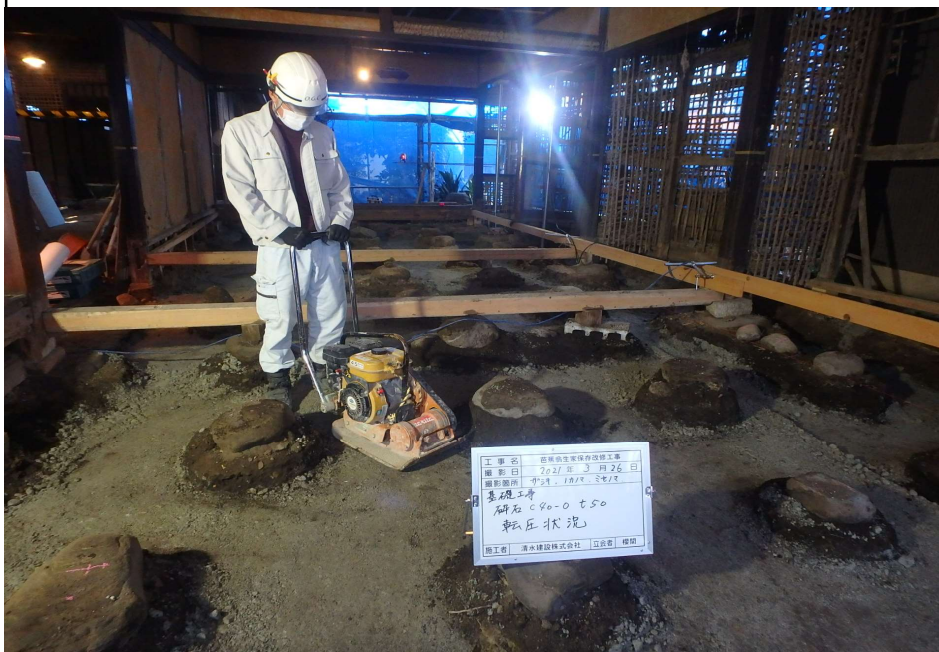
基礎工事 転圧状況
