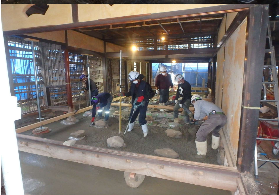
基礎工事 コンクリート打設
