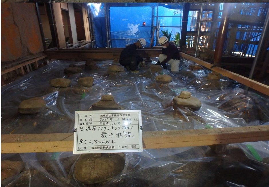
基礎工事 防湿フィルム敷込
