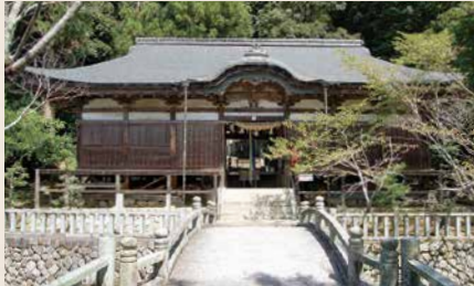
▲保存修理前の春日神社拝殿（南から）
