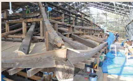
▲現在の春日神社拝殿上部（南西から）
