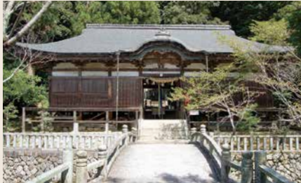
▲保存修理前の春日神社拝殿（南から）
