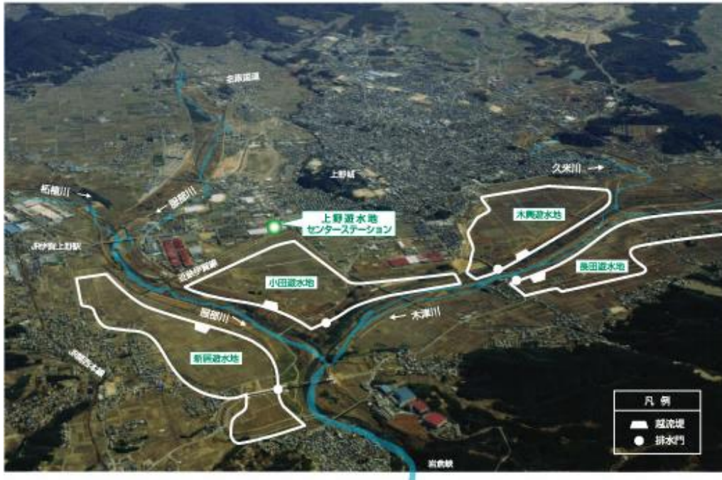
■上野遊水地全景（出典：木津川上流河川事務所ホームページ）
