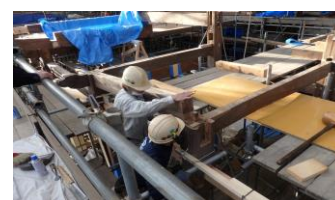
春日神社拝殿解体修理(組み立て作業)
