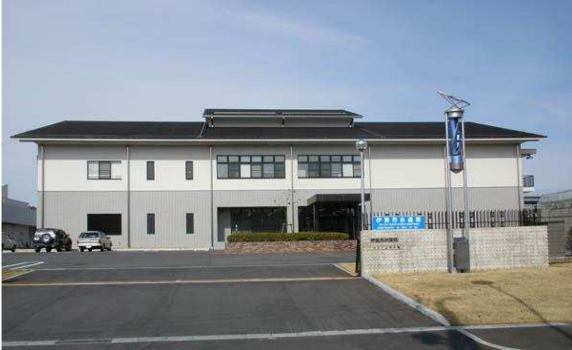
ゆめが丘浄水場
