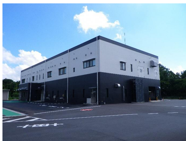
伊賀市浄化センター「さらら」
